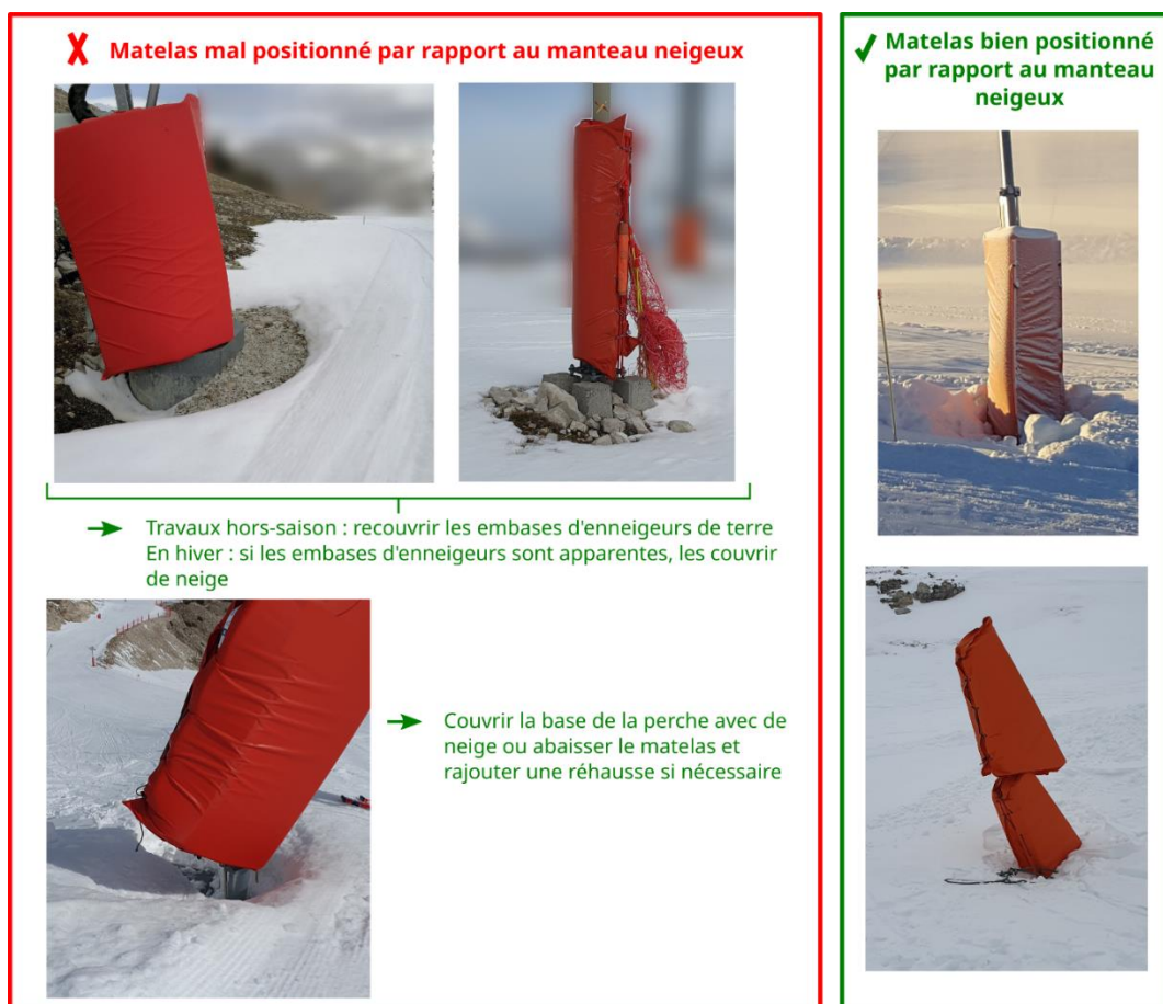
Exemples de bons et mauvais positionnements du matelas par rapport au manteau neigeux
